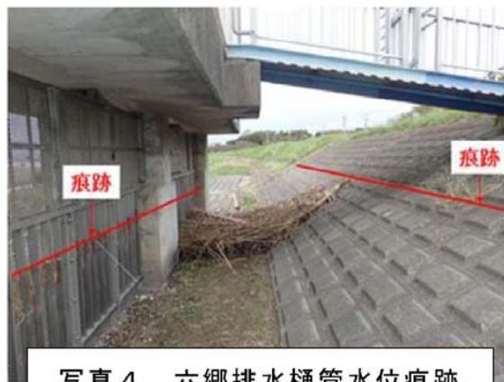
写真4 六郷排水樋管水位痕跡
