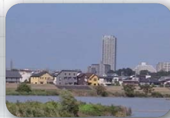
多摩川沿いのまちなみ
