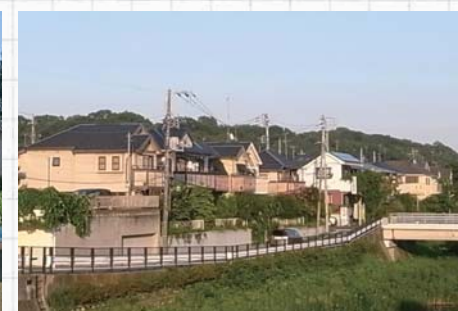
背景の国分寺崖線と調和した建物
