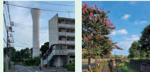
緑ヶ丘団地の緑と給水塔のある風景
