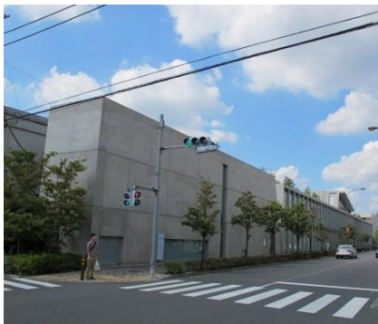
コンクリート打放しの施設
