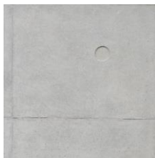
コンクリート打放し
