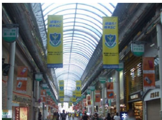
低層部の見やすい位置に形状、色彩を統一した突出広告、フラッグを設置することで、にぎわいともに連続性のある街並みを演出しています（宇都宮市）
