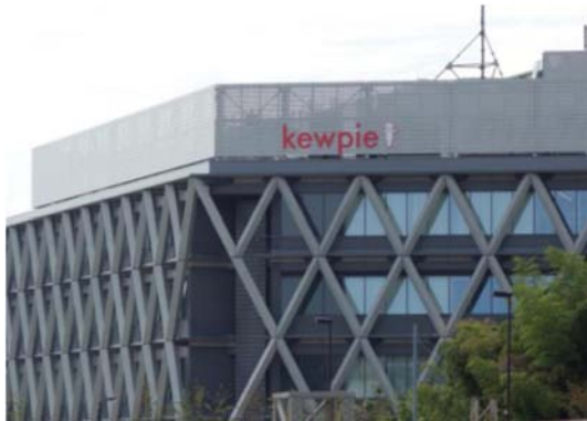
目を引く色づかいながらも表示を最小限に抑え、特徴的な広告物になっています（調布市）
