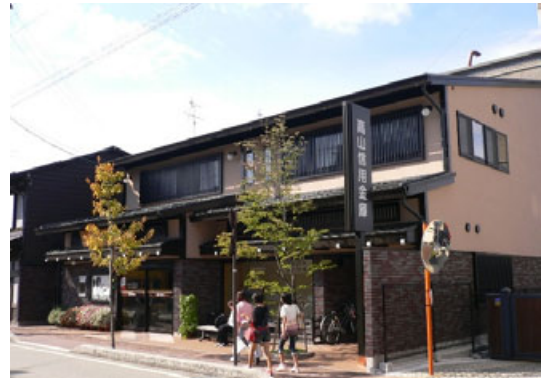
2階の軒先を超えない高さとすることで、周辺の街並みの景観を妨げないようにしています（高山市）
