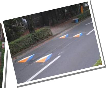
深大寺通りを通行する車両が『30km規制』を守っていただけるよう、「イメージハンプ」と呼ばれる路面の模様や、看板などを設置しました。設置工事は実験初日の11月8日（月）に実施しました。
