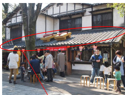
屋根と同様の素材の軒 (壁から60cm以上)
