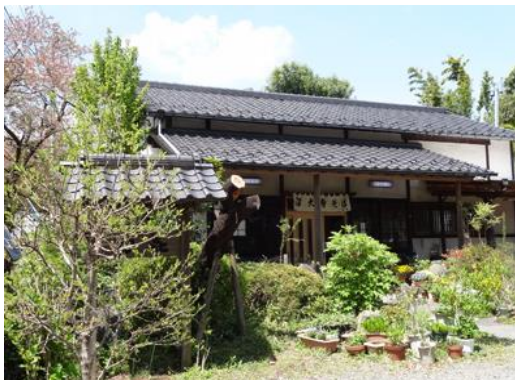
傾斜のある瓦屋根が深大寺地区で見られます
