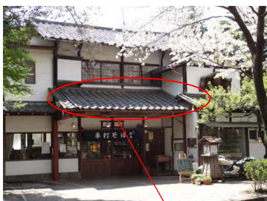
屋根と同様の素材の庇 (壁から60cm以上)
