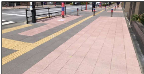
図 11 スタジアム通りの遮熱性ブロック舗装
