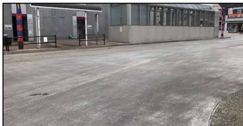
図 12 飛田給駅北口ロータリーの半たわみ性舗装
