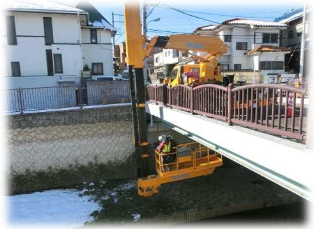
橋りょう点検車を使っでの点検
