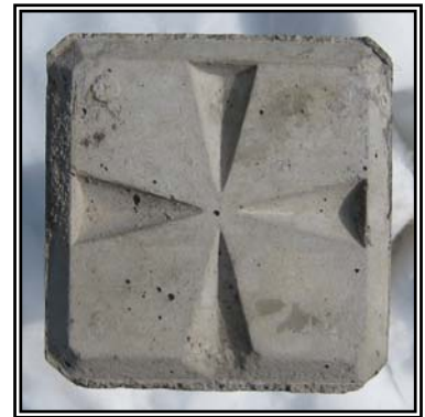
市石(コンクリート杭 十字)
