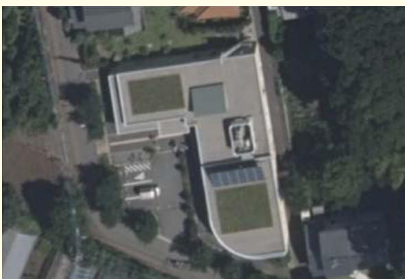
屋上緑化と太陽光発電設備のソーラーパネルを併設しています。(調布市立図書館深大寺分館)
