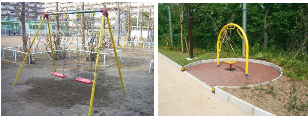
写真 3-1 左：支柱が錆びついたぶらんこ 右：健康遊具
