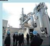
バイオマス発電所
