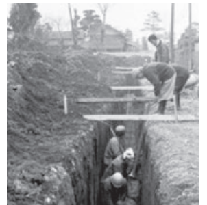
下布田辺下水道工事 昭和38年撮影
