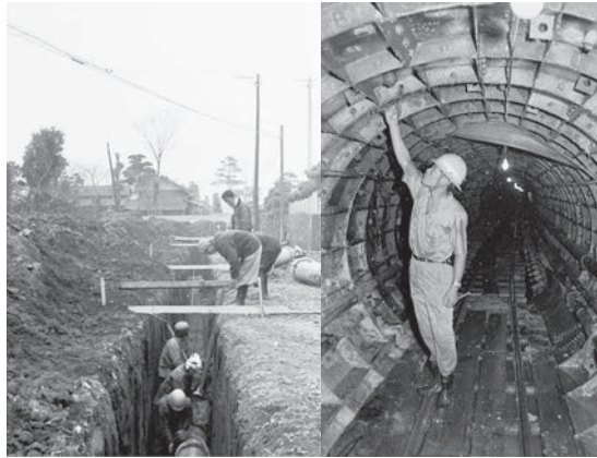
下水道工事のようす
