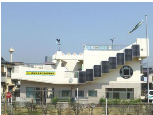
<多摩川自然情報館の太陽光パネル>
