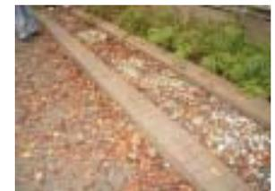
農場内の雨水浸透マス。雨どいがなく直接、雨だれを浸透させる設計。東宮御所にも同じ方式が設置されている。
