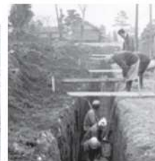
下布田辺下水道工事 昭和38年撮影
