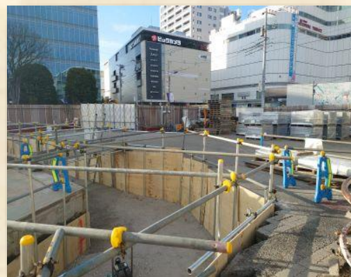
▲掘削工事の状況
