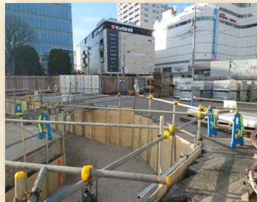
▲掘削工事の状況
