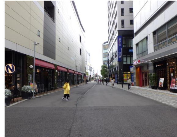
区画道路3号 現況写真
