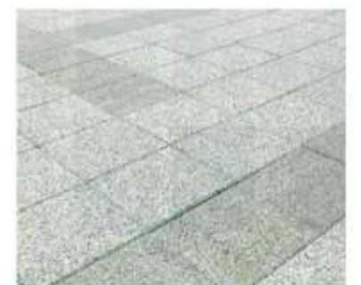
インターロッキングブロック舗装
