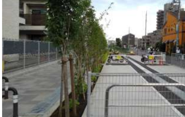
調布駅東側 自転車等駐車場
