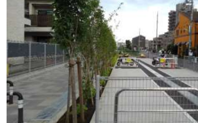
調布駅東側 自転車等駐車場
