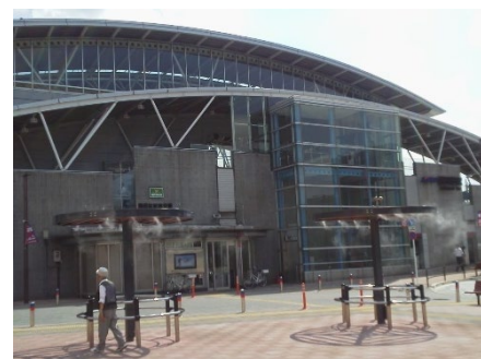
飛田給駅交通広場のパーゴラ及び微細ミスト
