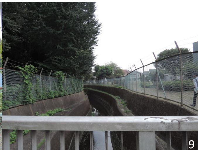
●府中用水はコンクリート3面貼りで、高いフェンスで囲まれている
