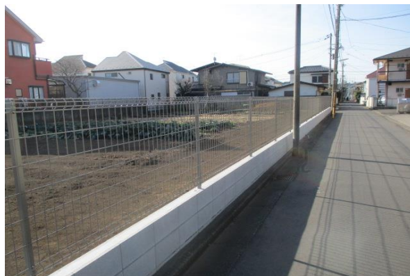
土留めフェンス整備
