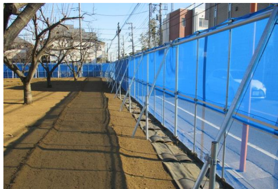
防薬ネット整備
