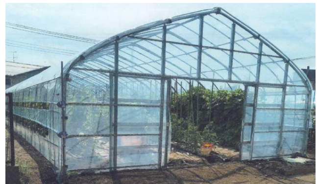
農業用ハウス整備
