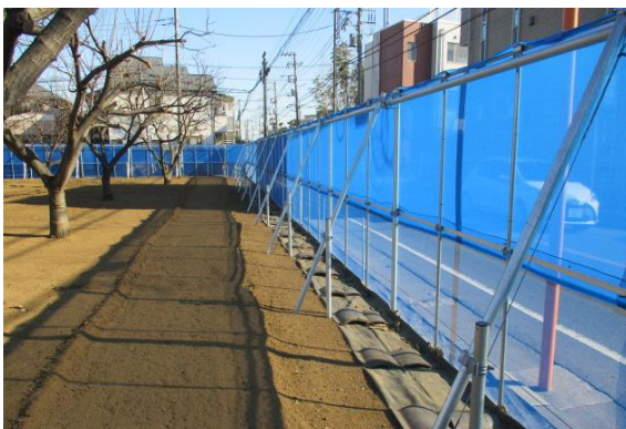
防薬ネット整備
