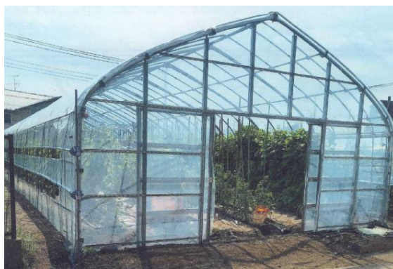
農業用ハウス整備
