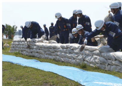
土のう作成訓練
