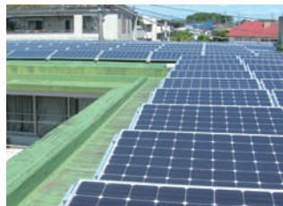
公民館屋上ソーラーパネル
