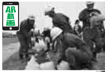
積み土のう工法
