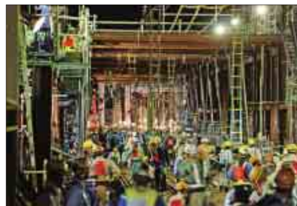
地下化切替工事の様子(西調布方取付部)
