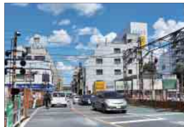
地下化後の旧調布1号踏切
