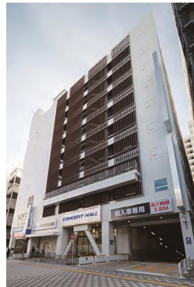
調布駅北第1B地区 施設建築物外観
