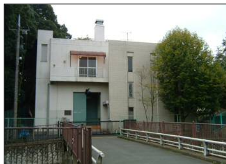
仙川中継ポンプ場
