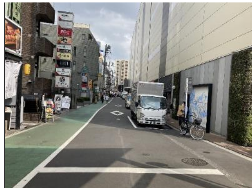
図 2.14 交通安全対策(カラー舗装化)
