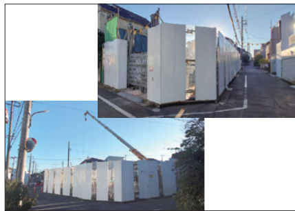
地盤補修工事の現場
