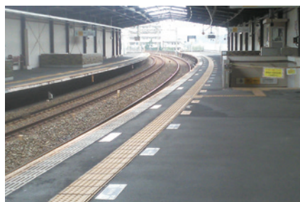
転落防止柵がない京王多摩川駅ホーム
