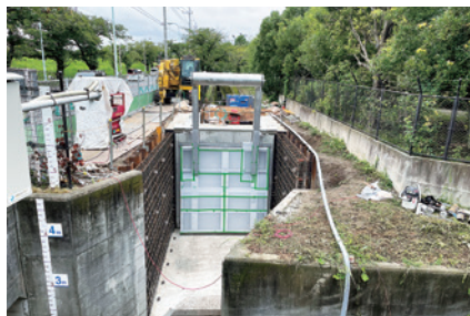
根川第一雨水幹線のフラップゲート(工事中)
