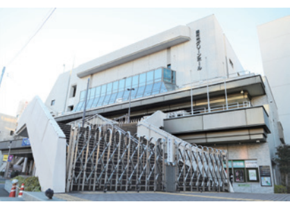
更新に向けて取組を進めているグリーンホール
