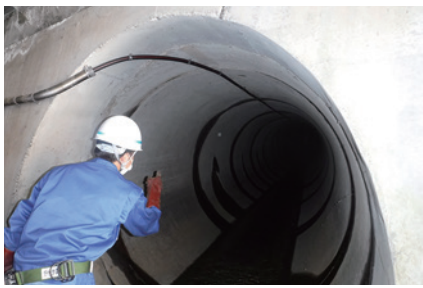
道路・下水道の維持管理
