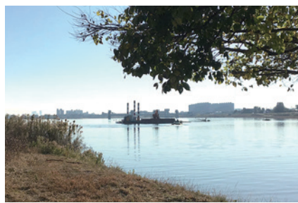
多摩川河道掘削工事現場の作業船 (2年12月)
