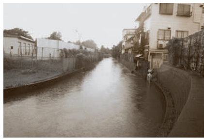
台風 19 号で増水した調布幹線
