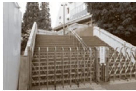
グリーンホールの屋外階段
