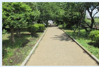
舗装(脱色アスファルト舗装)
