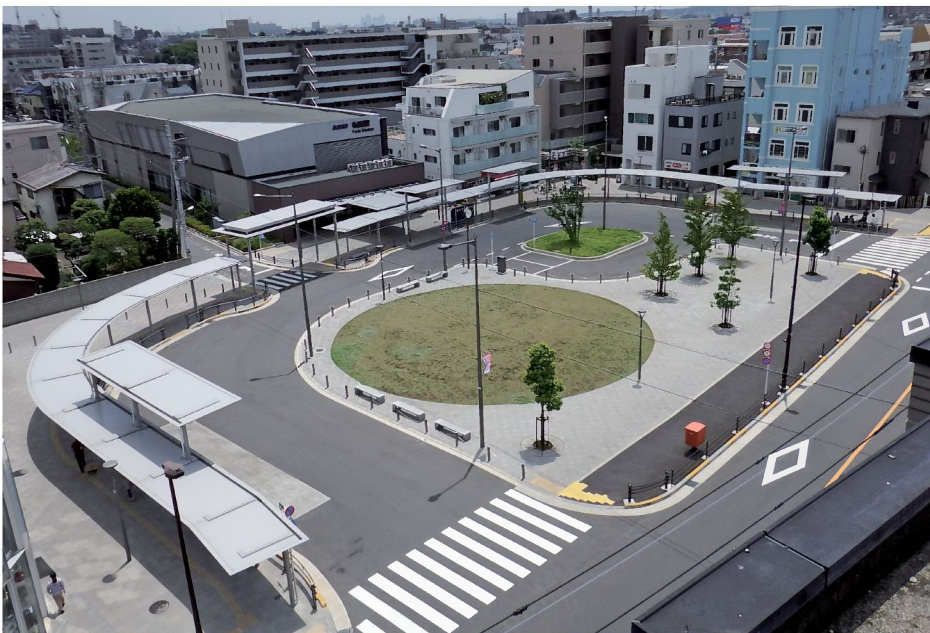
布田駅前広場を北西側から撮影
