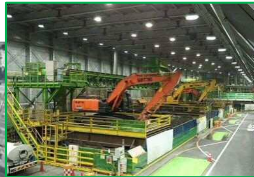
土砂ピット(南行)内部 (構築中)
