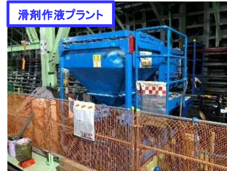
滑剤充填設備(大泉本線(北行)シールドトンネル工事の実績)
