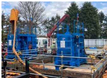
地盤補修マシン 地盤の削孔および改良体の造成
