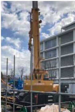
20tラフタークレーン 資機材積み下ろし等
