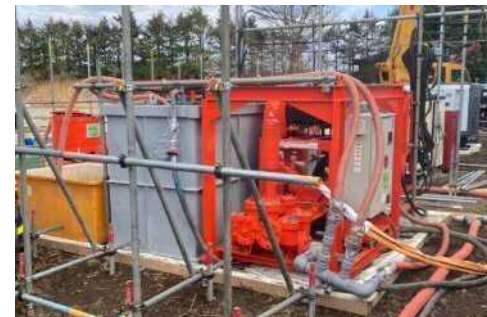
ボーリングポンプ 削孔時の水送り込み
