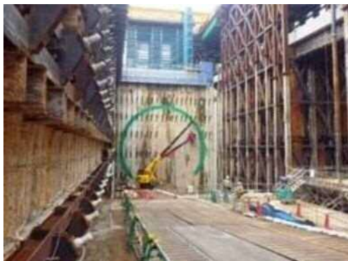
工事の写真(イメージ)
