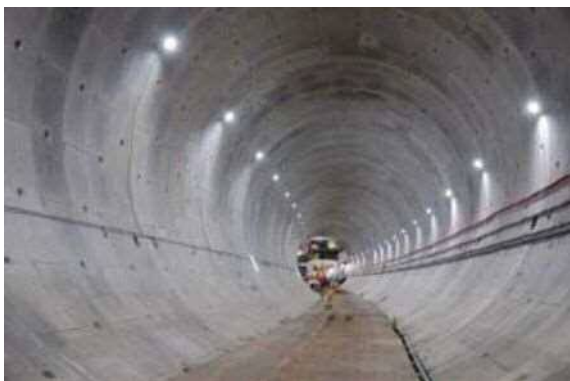
トンネル内部の写真(イメージ)
