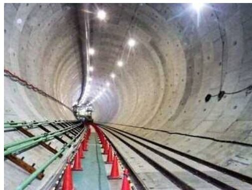
トンネル内部の写真(イメージ)
