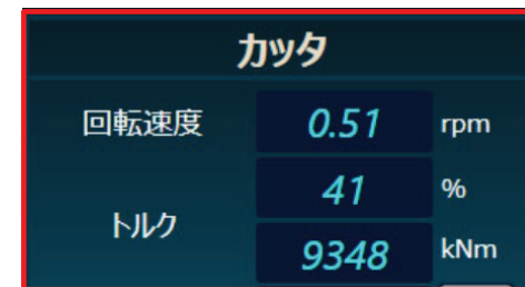
カッタートルクのリアルタイム監視状況
