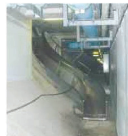
すべり台(路面下から)
